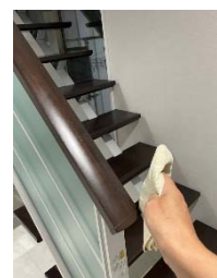
階段の手すり
